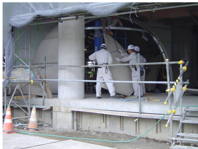
10/23 コンクリートのパネルを組み合わせていきます。 まるで立体パズルみたいですね。
