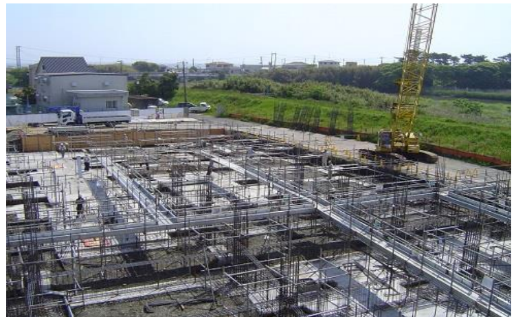
5/14 あっという間に足場が組み、基礎の型枠が作られていきます。
