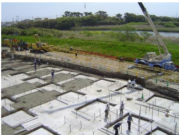
5/7 基礎の下に敷くこのコンクリートは「捨てコン」といいます。基礎工事を正確に行うためのものなので、決して捨ててしまうわけではありませんよ。
