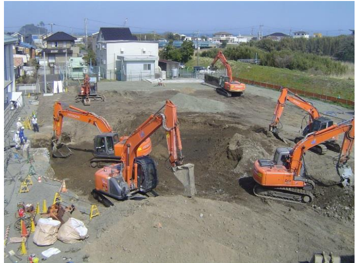
3/31 ショベルカー6台稼働中！
