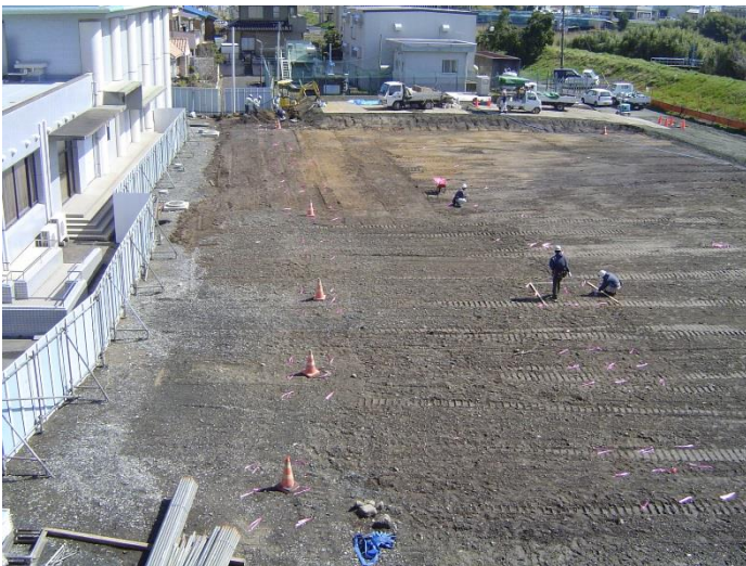
4/1 まっさらの更地になりました。これから地震に負けないよう地盤改良工事を行っていきます。
