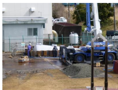
浄化槽の埋め込み作業中です。
