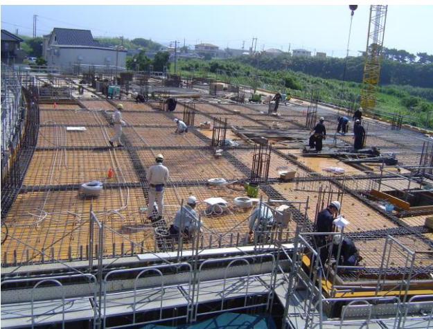
8/9 2階床部分配筋作業。 暑い中の作業はとても大変です。 職人さんたちの作業着には、よく見ると小さなファンがついているものが！ハイテクですね。
