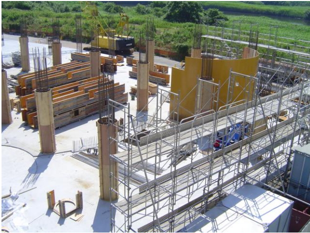
7/11 いよいよ2階部分に取り掛かります。 まずは足場を設置。
