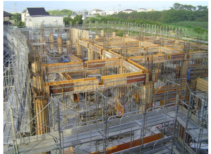
7/16 柱と1階の梁部分の型枠を組み立てていきます。
