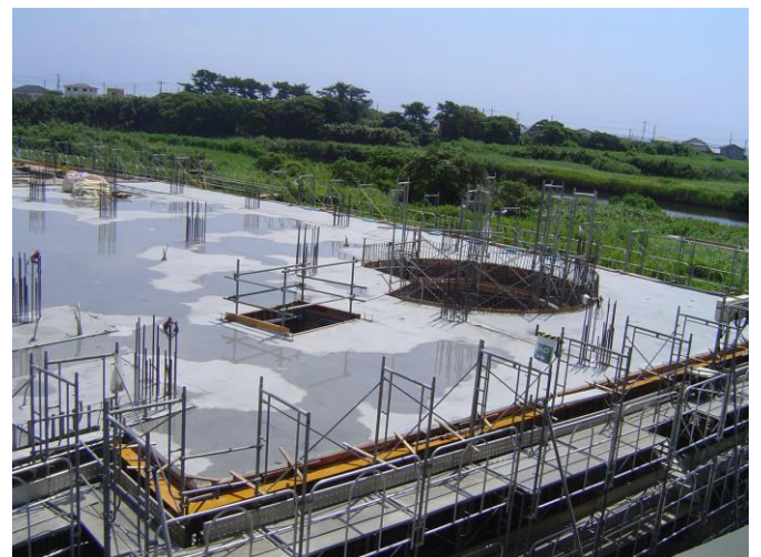
8/14 2階床部分のコンクリートも流し終わりました。 一晩でがらりと風景が変わってしまってびっくりです。
