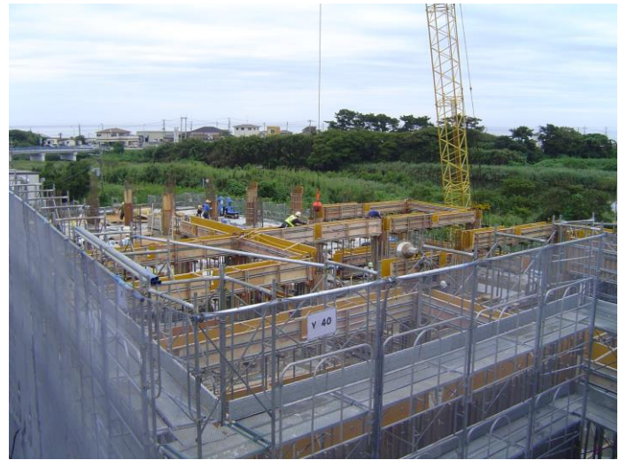
9/3 そして柱と梁。
