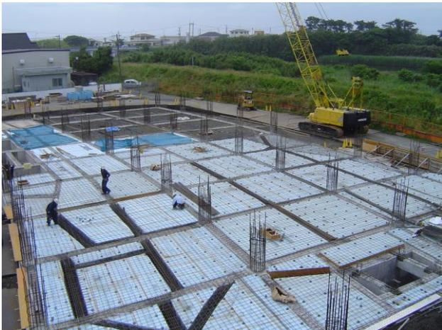
6/20 埋め戻した土の上にコンクリートを流し、さらにその上に断熱材と鉄筋を配します。
