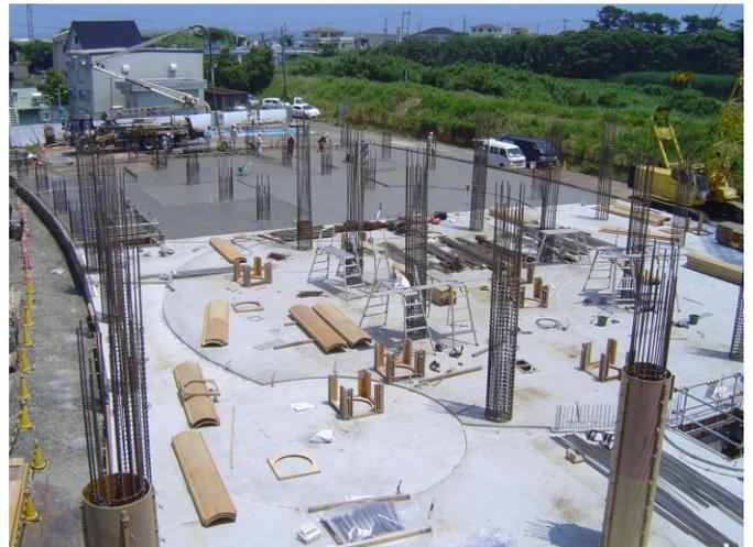
7/9 柱の鉄筋を溶接して伸ばし、木の型枠をかぶせていきます。
