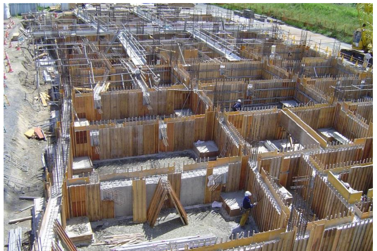
6/3 型枠をはずすと中からコンクリートの基礎が登場です。
