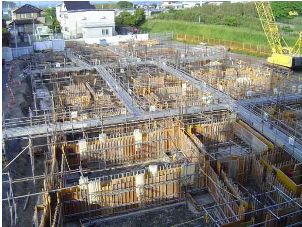
5/29 型枠にコンクリートを流し込みました。
