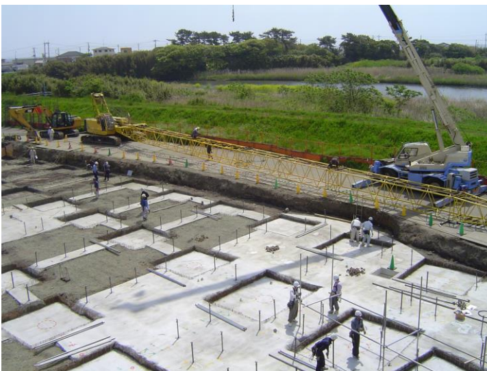
5/7 基礎の下に敷くこのコンクリートは「捨てコン」といいます。基礎工事を正確に行うためのものなので、決して捨ててしまうわけではありませんよ。
