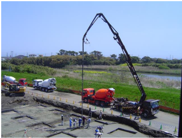
4/16 ミキサー車につながれたこの車が、長いホースのようなものでコンクリートを流し込んでいきます。
