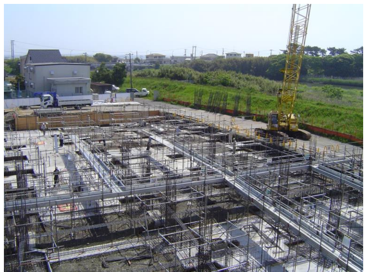
5/14 あっという間に足場が組み、基礎の型枠が作られています。
