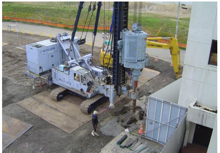
こんな風に穴を掘りながらコンクリートと土を混ぜたものを流し込むそうです。
