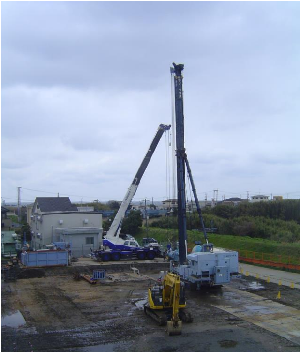
4/16 この大きな機械で杭を打ちます。
