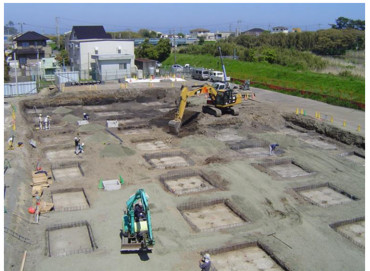
4/29 杭打ち終了後です。一ヶ所に 9 本ずつ丸い杭が入っているのが見えますか？
