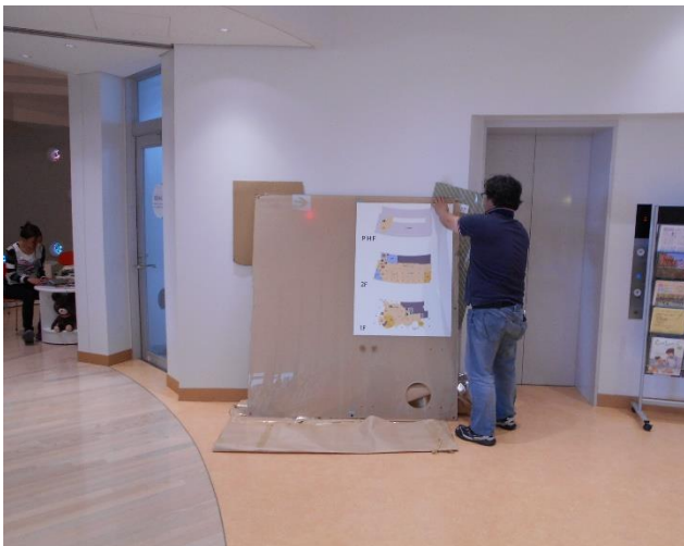
5/30 館内の案内図も急ピッチで取り付け中です。
