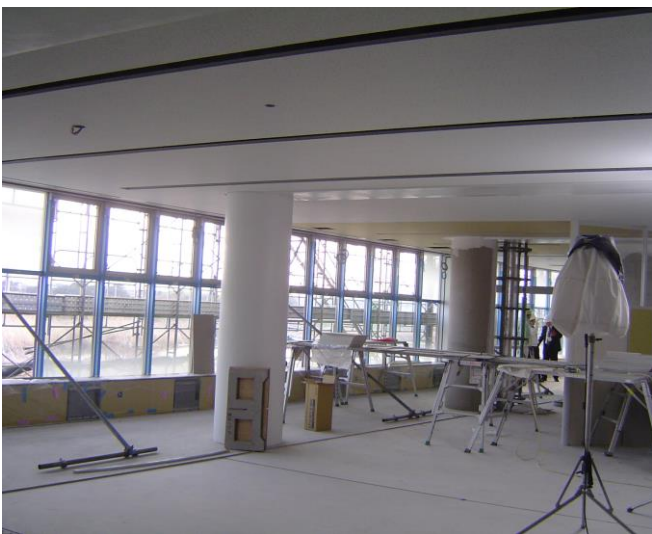
2階はもう天井が張られています。穴が開いている部分には電灯が入ります。
