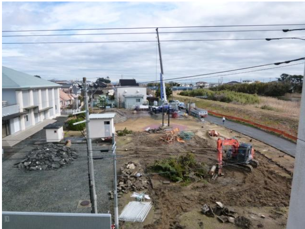
3/4 のっぽのクレーンで浄化槽を設置中です。
