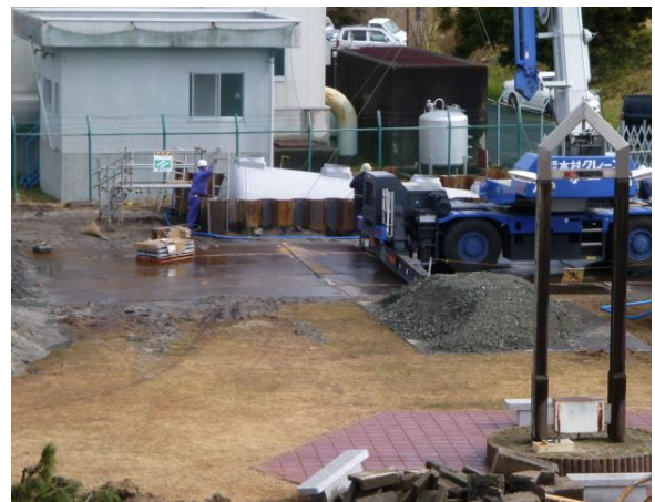
この巨大な浄化槽はなんと300人槽！
